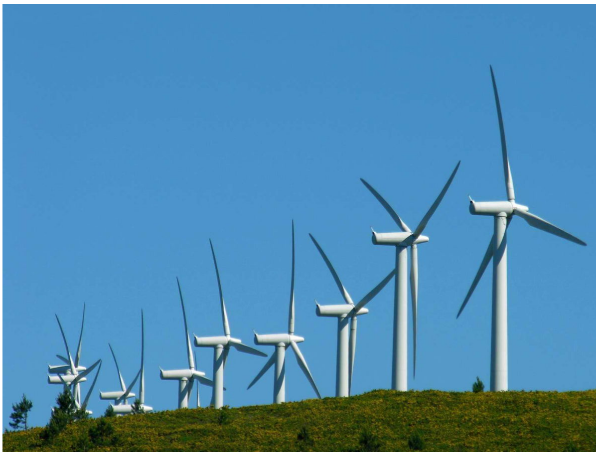
Enerxía eólica – O Pindo
